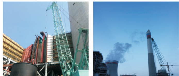
图1 台二现场MGGH烟气再热器模块吊装
