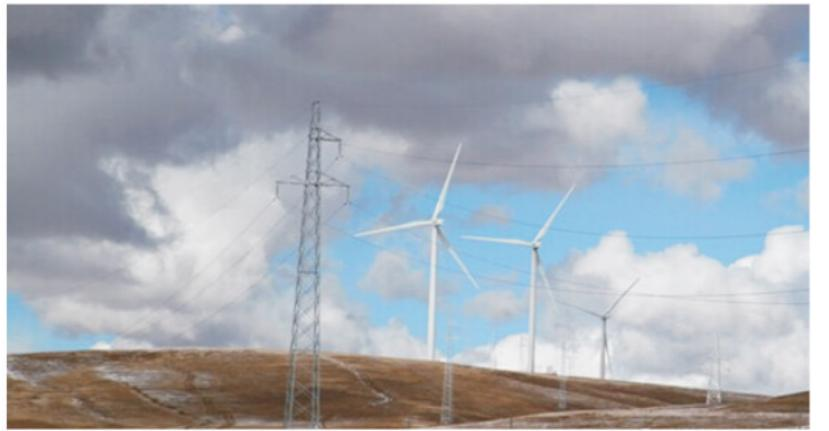
目前龙源那曲高海拔试验风电场还处于试运营状态，仅仅建设了5台风机，这5台风机塔筒内安装的全都是日风生产的2MW双馈变流器（考虑到海拔影响，2MW变流器降容为1.5MW变流器使用），2014年年底试运营结束，现如今一切情况稳定。
